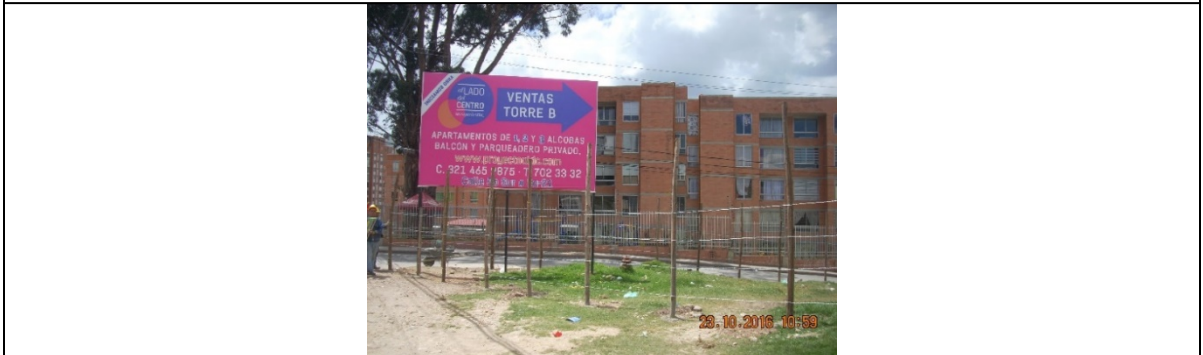
FOTOGRAFÍA 3: Vista de elemento instalado en espacio público, se observa instalación de cerramiento, sentido Norte – Sur.
