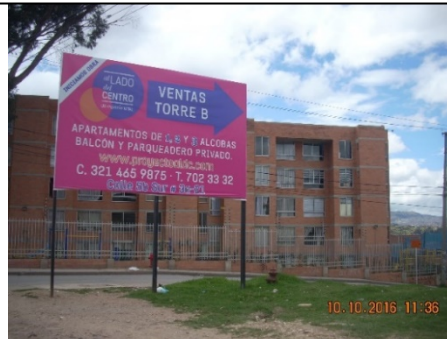
FOTOGRAFÍA 3: Vista de elemento instalado en espacio público, Sentido Norte – Sur, se evidencia que no esta dentro de la obra.
