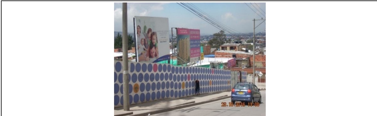
FOTOGRAFÍA 1: Vista Panorámica de los dos elementos instalados en el predio Calle 5b sur No. 3ª – 21, sentido Oriente Occidente, los cuales no cuentan con registro
